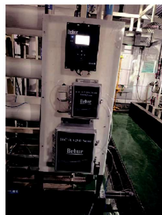
河南某电子材料工厂（单晶硅）项目
